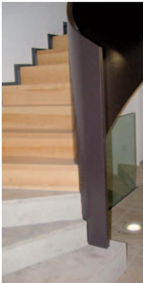
Die Spindeltreppe trägt sich über eine ellipsenförmig nach oben schraubende Treppenwange selbst. Alle Stufen und Podeste beziehen sich auf einen Mittelpunkt
